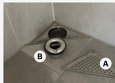
A – Rist B – Vandlås. Den sorte membran smøres med glidemiddel
