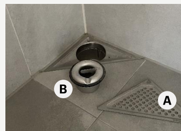
A – Rist B – Vandlås. Den sorte membran smøres med glidemiddel
